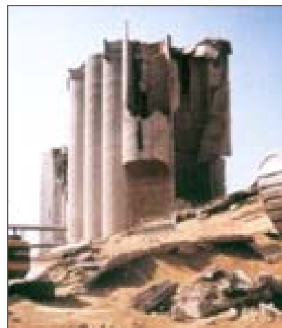
Explosion de silo
