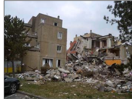
Explosion de gaz à WITRY LES REIMS en avril 2013.
