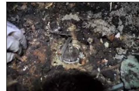
Spot très basse tension dans la ouate de cellulose.
