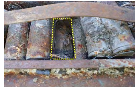
Cellule se trouvant au centre de la batterie lithium-ion retrouvée éventrée (pointillés jaunes).
