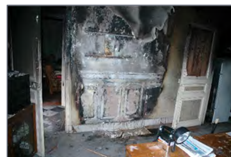
Impact thermique à l'emplacement du téléviseur.
