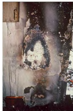
Incendie d'un réfrigérateur plaqué contre une cloison.
