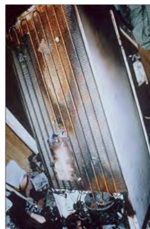
Départ de feu au niveau d'un congélateur encastré
